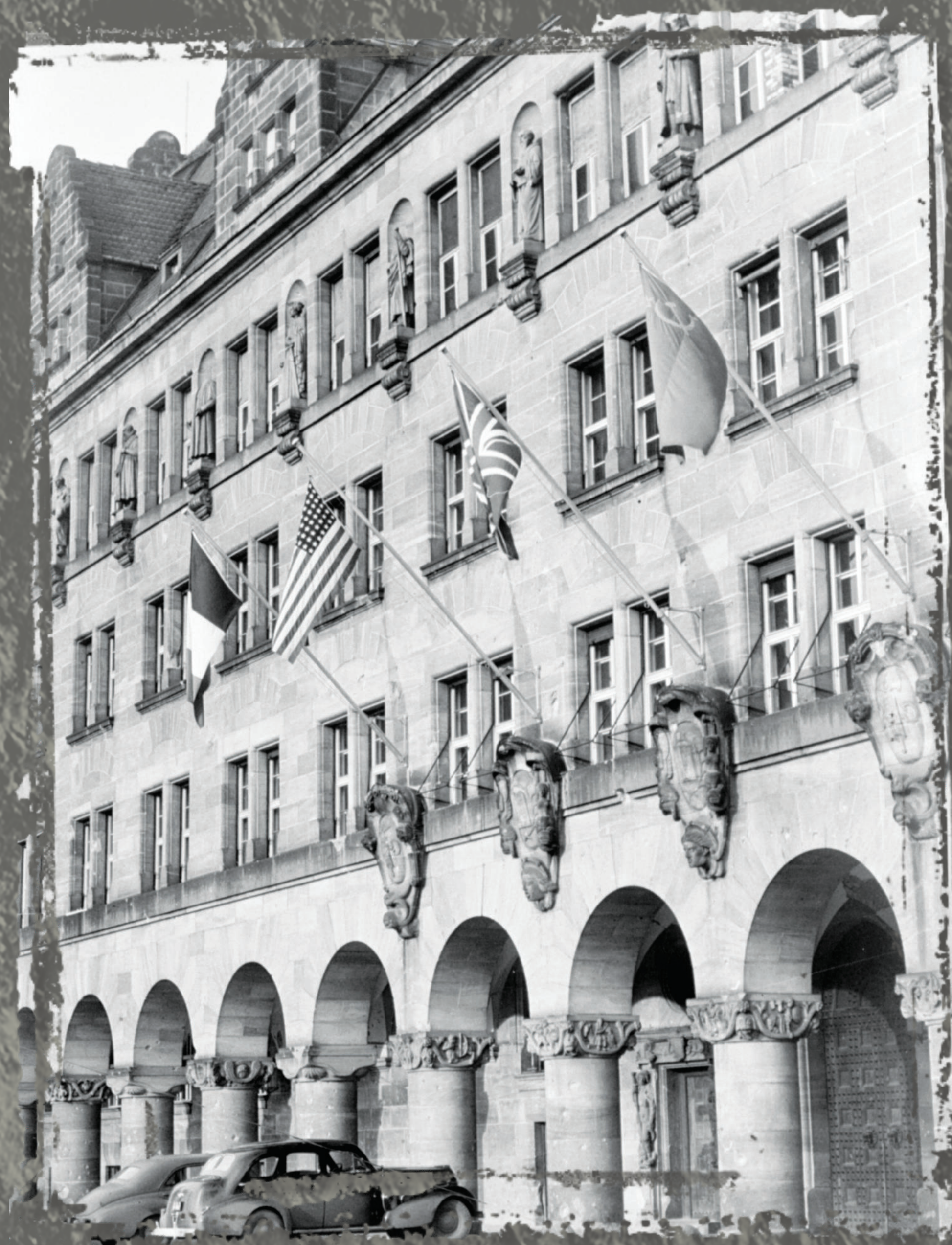
Здание Дворца юстиции, где проходил Нюрнбергский процесс. 1945 г. Фото Е.А. Халдея. РГАКФД. № В-2449.
